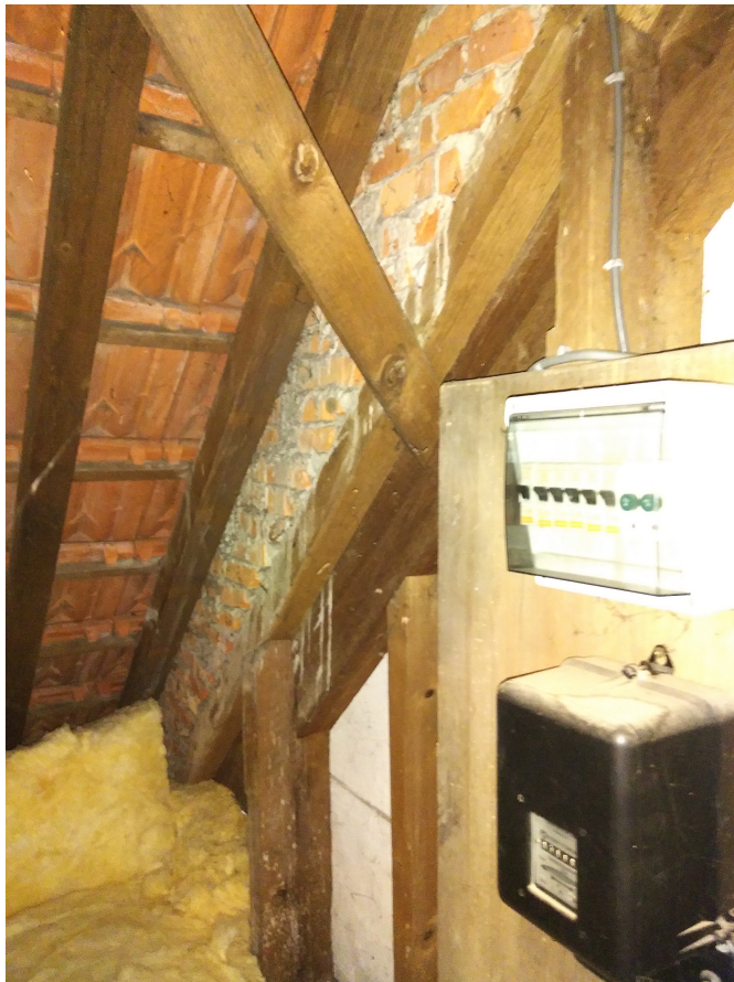
extra verdieping gemetst op houten structuur.
