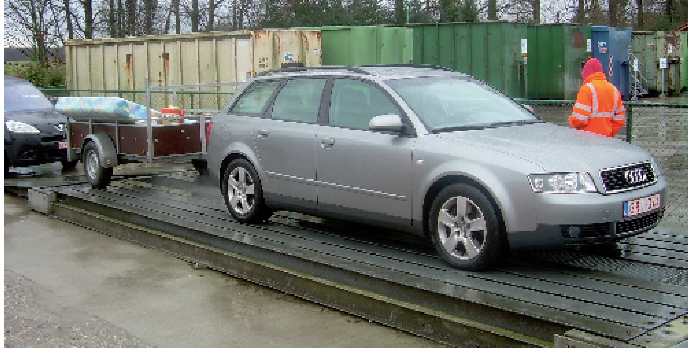
De weegbrug registreert het volledige gewicht van uw wagen, aanhangwagen en afvalstoffen. Na het deponeren van de afvalstoffen worden wagen en aanhangwagen opnieuw gewogen.
