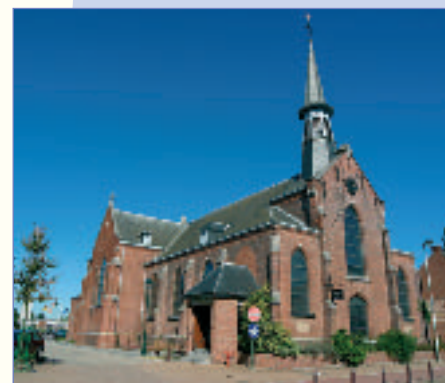
De meest ingrijpende restauratiewerken hebben buiten plaatsgevonden. Het vermolmd dakgebinte van de kerk was de aanleiding voor de werken. Het dak, de leien, de zolder, de bliksembeveiliging... ze kregen allemaal een beurt
