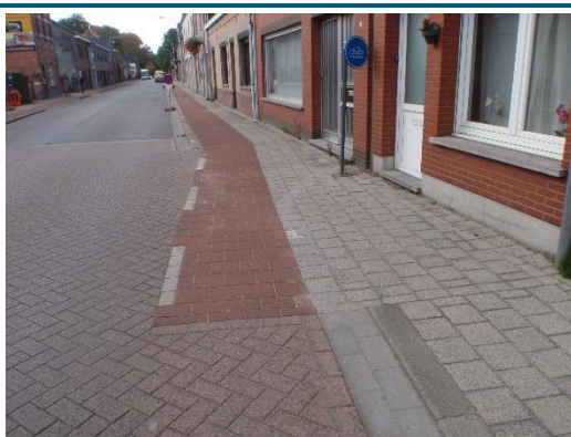
Figuur 22: Begin enkelrichtingsfietspad Halle-Dorp - Driesheide
