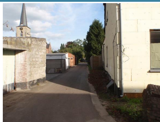
Figuur 52: Smalle doorgang t.h.v. Halle-Velden x Kerkhofweg en plaatsing verbodsbord (vanuit Halle-Velden)
