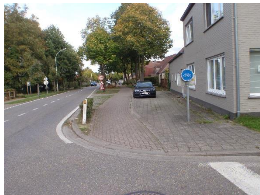
Figuur 19: Enkelrichtingsfietspad Halle-Dorp - Berkenlaan
