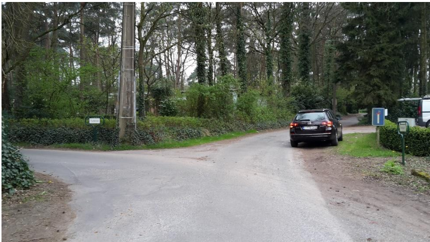
Lokale woonstraat (lokale weg type III) Bebouwde kom - zone 50 Weginrichting in asfalt (geen voetpaden – geen fietspaden) – tussen 3,05m en 3,30m
